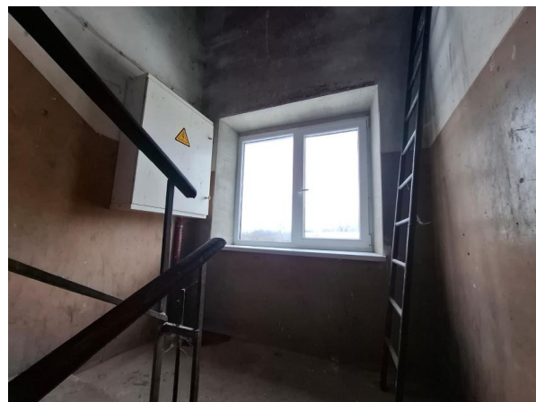
Kāpņu telpa pie vērtējamā objekta
