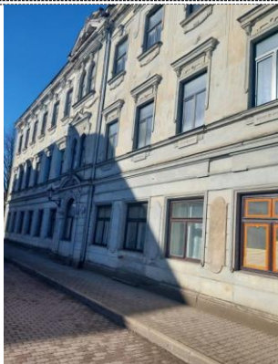
Ēkas fasāde no ielas puses
