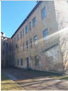
Dzīvojamās ēkas fasāde
