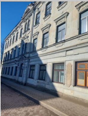
Ēkas fasāde no ielas puses
