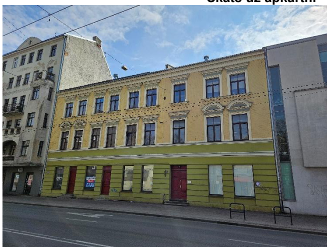
Ēkas fasāde, kurā atrodas vērtēšanas objekts
