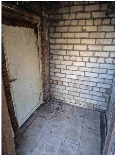
Piebūves (telpa Nr.14)
