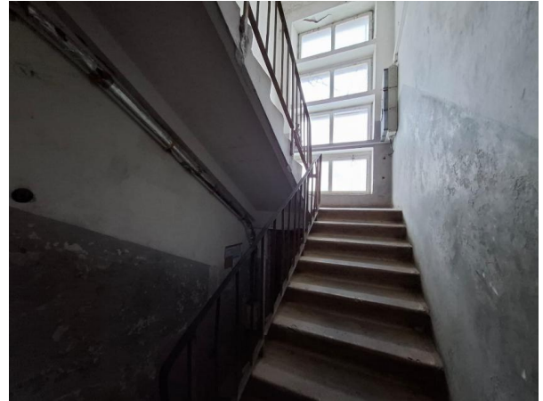
Kāpņu telpa pie vērtējamā objekta
