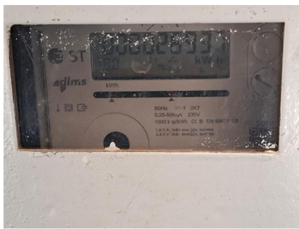
Dzīvokļa elektrības skaitītājs elektrības skapī
