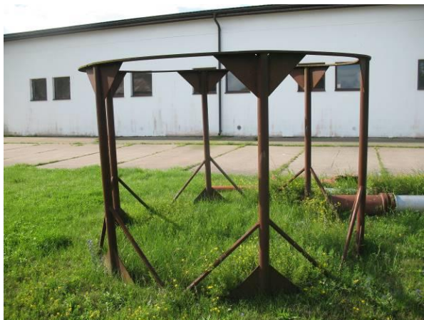
Dzinekļa statīvs remonta laikā
