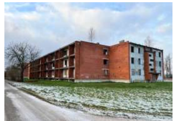
Jaunbūve ar kadastra apzīmējumu 9884 013 0256 001
