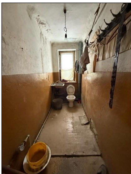
Sanitārais mezgls, telpa nr.5
