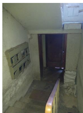
4.attēls. Kāpņu telpa
