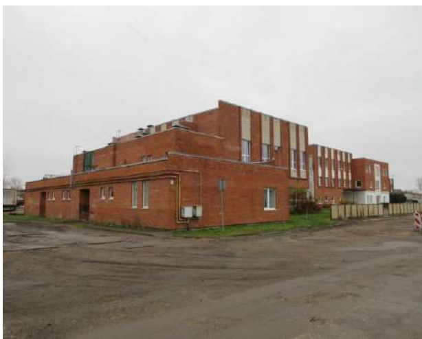
Ēku komplekss, skats no Rūpniecības ielas
