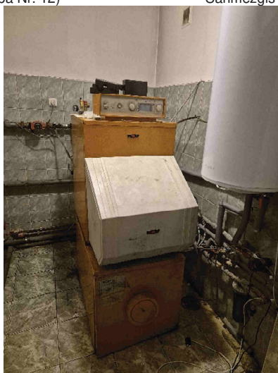
Katlu telpa (telpa Nr. 9)
