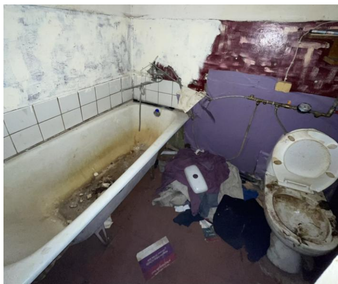
Savienotā sanitārtehniskā telpa nr.5
