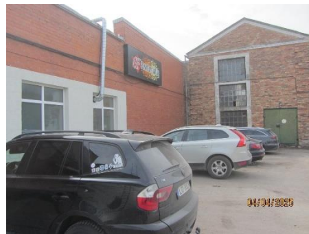
Remontu ceha celtniecības ēkas fasāde
