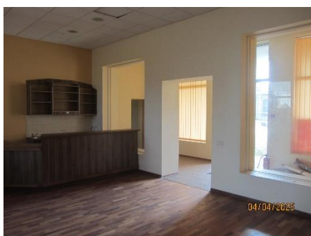
Remontu ceha celtniecības ēkas iekšskats
