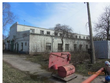
Remontu ceha celtniecības ēkas fasāde
