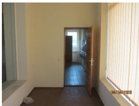
Remontu ceha celtniecības ēkas iekšskats
