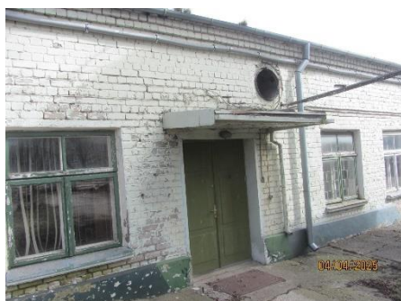
Remontu ceha celtniecības ēkas fasāde
