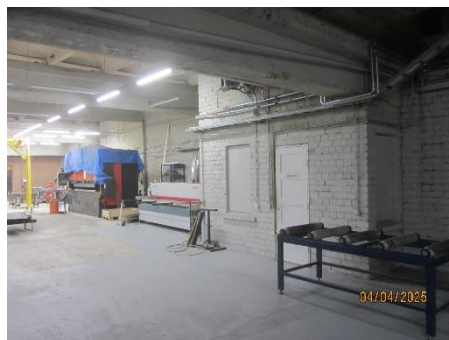
Remontu ceha celtniecības ēkas iekšskats
