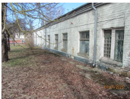
Remontu ceha celtniecības ēkas fasāde
