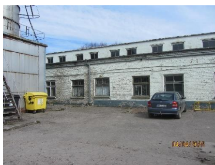
Remontu ceha celtniecības ēkas fasāde
