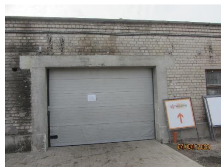
Remontu ceha celtniecības ēkas fasāde
