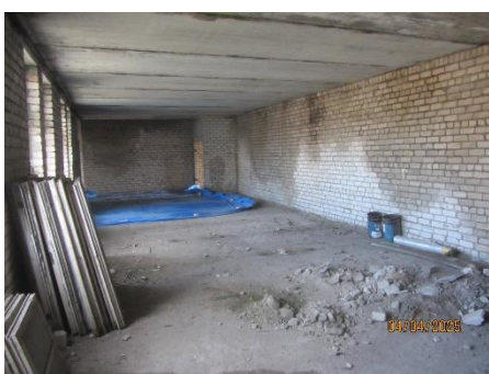
Remontu ceha celtniecības ēkas iekšskats
