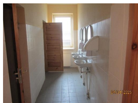
Remontu ceha celtniecības ēkas iekšskats
