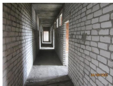
Remontu ceha celtniecības ēkas iekšskats
