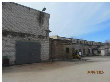
Remontu ceha celtniecības ēkas fasāde
