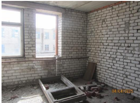
Remontu ceha celtniecības ēkas iekšskats
