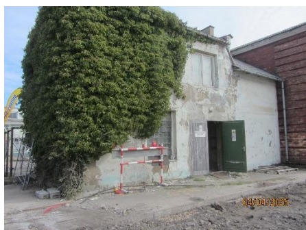
Remontu ceha celtniecības ēkas fasāde
