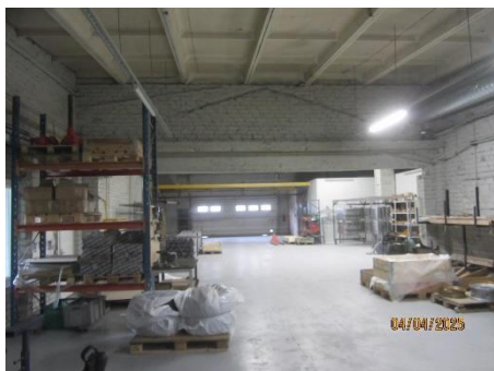
Remontu ceha celtniecības ēkas iekšskats
