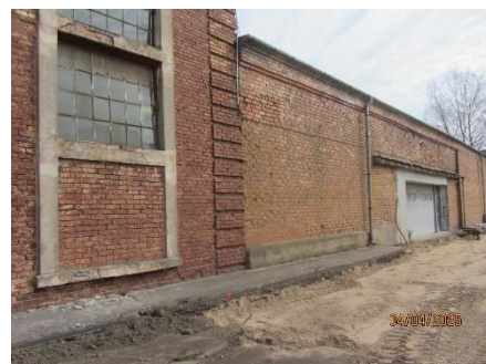
Remontu ceha celtniecības ēkas fasāde
