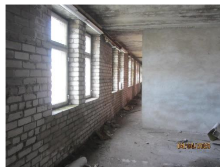
Remontu ceha celtniecības ēkas iekšskats
