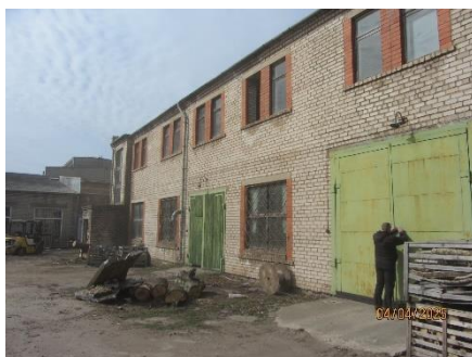
Remontu ceha celtniecības ēkas fasāde
