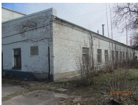
Remontu ceha celtniecības ēkas fasāde
