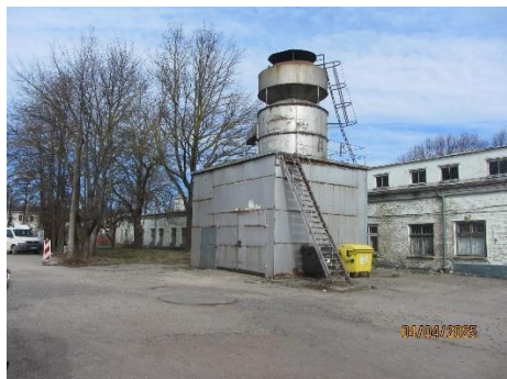
Remontu ceha celtniecības ēkas fasāde
