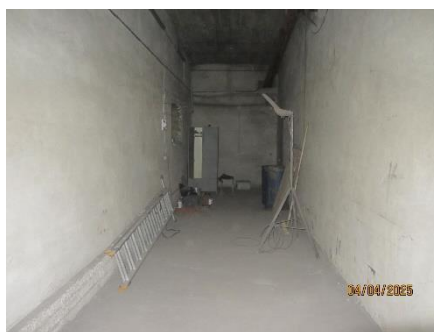
Remontu ceha celtniecības ēkas iekšskats
