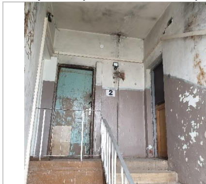
Kāpņu telpas mājā
