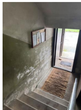
4. attēls. Kāpņu telpa
