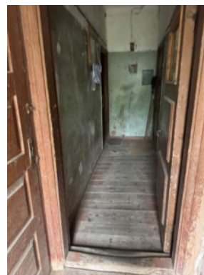
4. attēls. Kāpņu telpa
