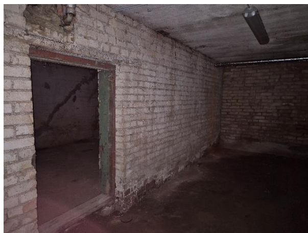
Nedzīvojama telpa (telpa Nr.1), ieeja telpā Nr.2
