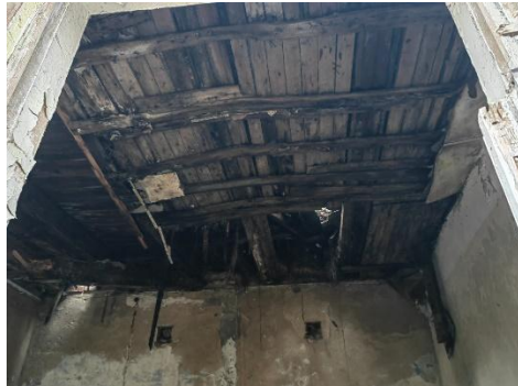
2.4.3. att. Iegruvis starpstāvu pārsegums (foto no 18.01.2023.)
