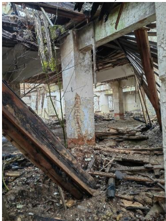
2.4.5. att. Iegruvis starpstāvu pārsegums (foto no 18.01.2023.)
