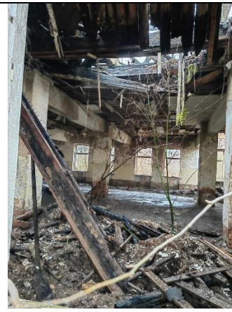
2.4.2. att. Iegruvis starpstāvu pārsegums (foto no 18.01.2023.)
