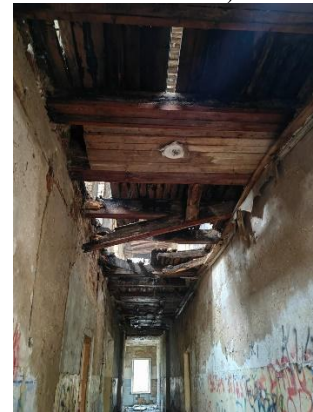
2.4.4. att. Iegruvis starpstāvu pārsegums (foto no 18.01.2023.)
