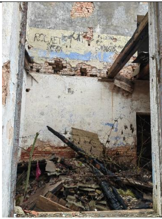
2.4.1. att. Iegruvis starpstāvu pārsegums (foto no 18.01.2023.)
