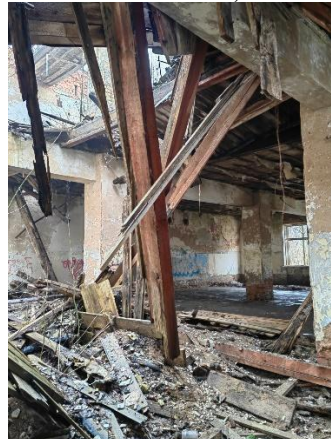
2.4.6. att. Iegruvis starpstāvu pārsegums (foto no 18.01.2023.)
