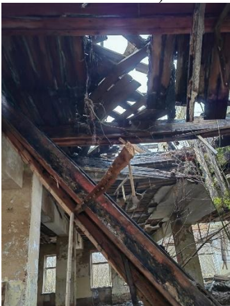
2.4.7. att. Iegruvis starpstāvu pārsegums (foto no 18.01.2023.)
