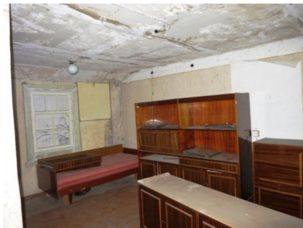
Jumta stāva telpas nr. 22
