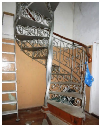
Gaitenis 1.stāvā. Telpa nr. 16.
