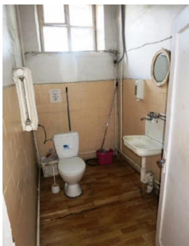
Sanitārtehniskā telpa 1.stāvā, Nr. 15.
