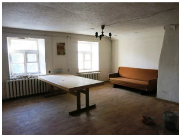
Jumta stāva telpas nr. 20
