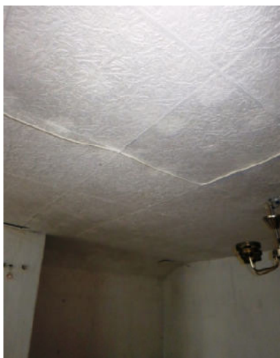
Jumta stāva telpas nr. 22
