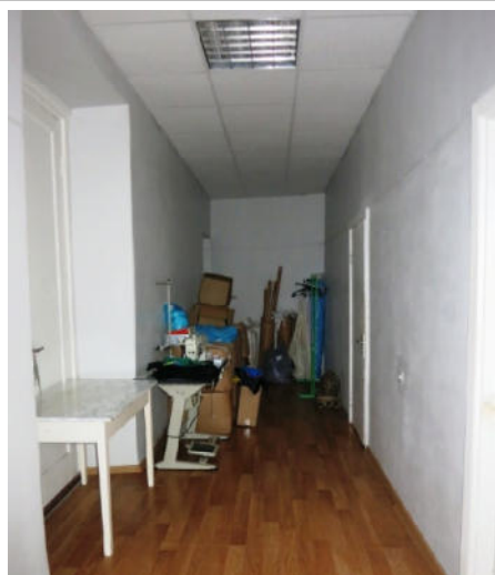
Gaitenis 1.stāvā, telpa nr. 5
