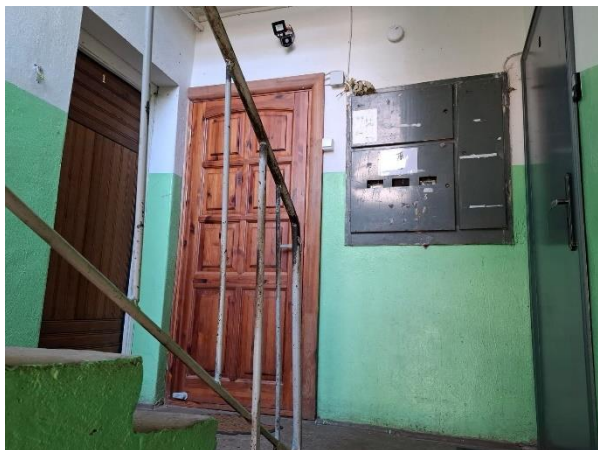
Kāpņu telpa pie vērtējamā objekta
