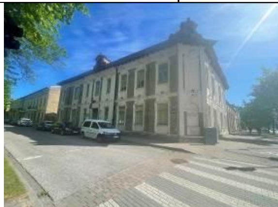
Universitātes ēkas iela fasāde. Skats no Kuldīgas ielas un Lielā prospekta krustojuma.
