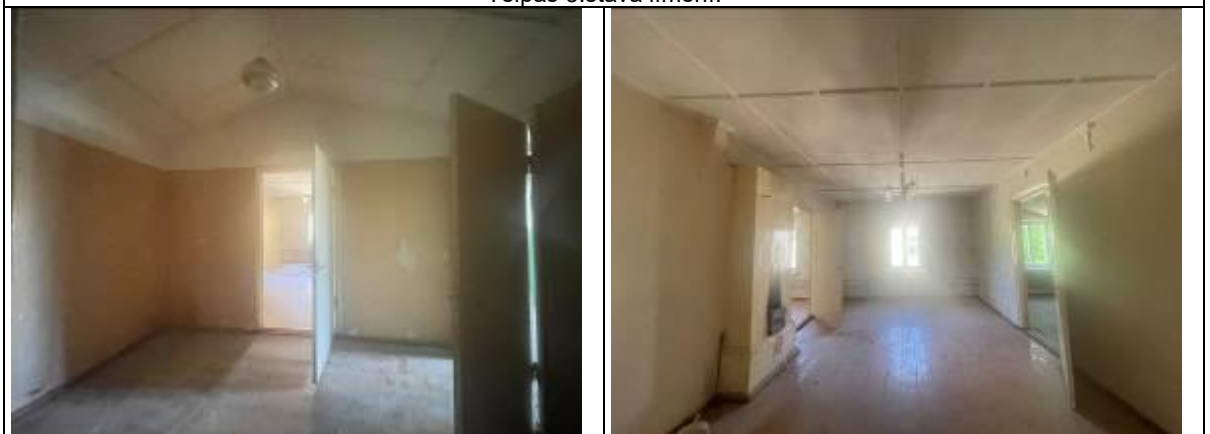
Telpas 3.stāva līmenī.
