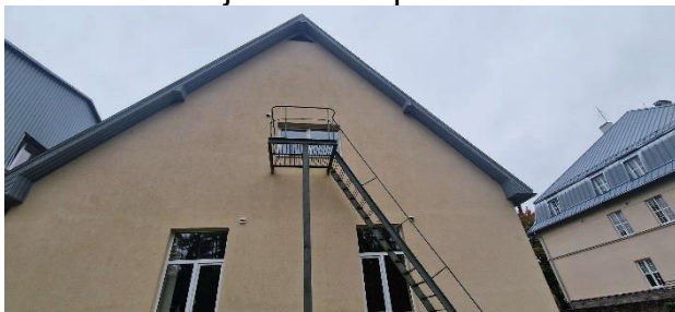
Foto 4.2.5 vecais korpus. Z fasāde
