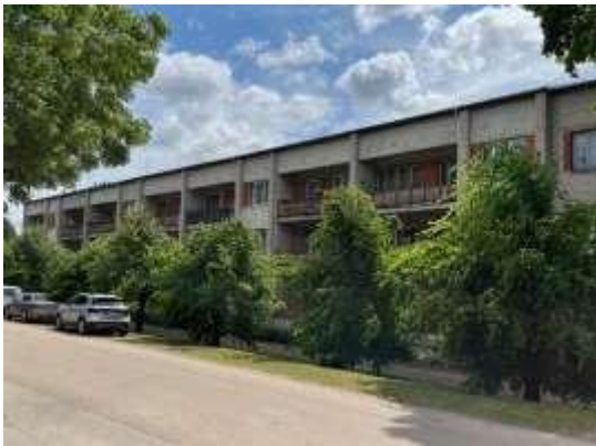
Daudzdzīvokļu dzīvojamās ēkas fasāde
