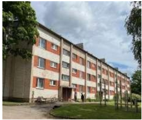
Daudzdzīvokļu dzīvojamās ēkas fasāde
