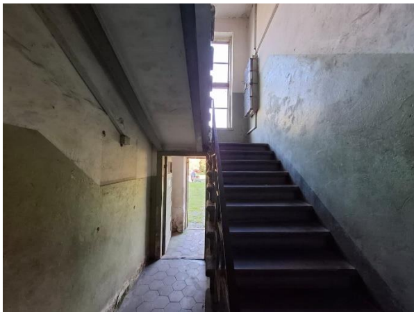
Kāpņu telpa pie vērtējamā objekta
