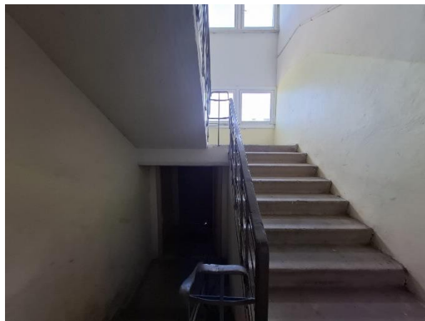
Kāpņu telpa pie vērtējamā objekta
