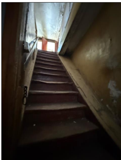
Kāpņu telpa, telpa nr.6
