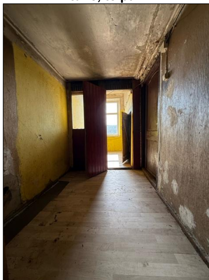
Kāpņu telpa, telpa nr.6
