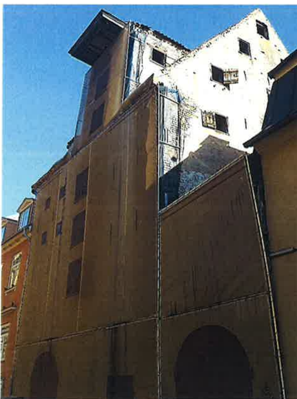
1. attēls. Galvenā fasāde
