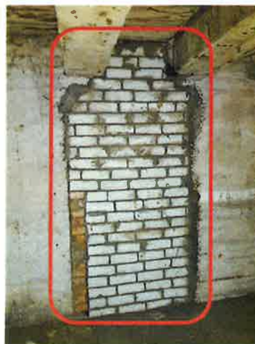
30.attēls. Aizmūrēta aile uz Lit.001
