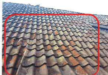
105.attēls. Bojāta kārniņu virsma
