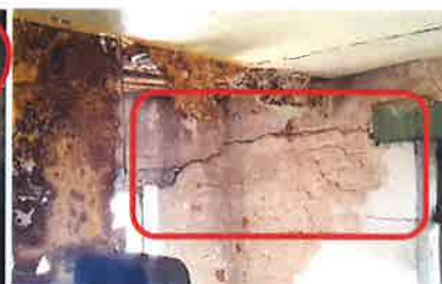
38.attēls. Jumta izbūves sienas
