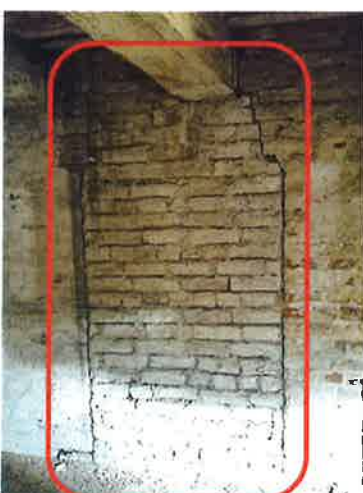
29.attēls. Aizmūrēta aile uz Lit.001
