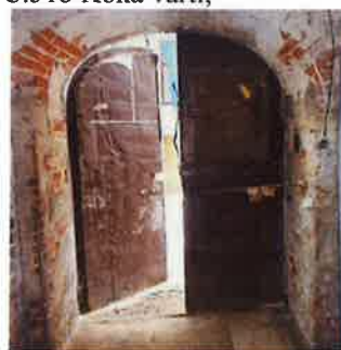
134.attēls. No iekšpuses koka vārti apšūti ar skārdi
