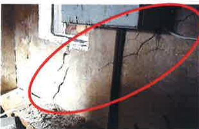
37.attēls. Jumta izbūves sienas
