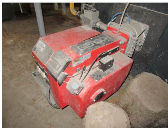
Pampāļu ciema gāzes katlumājas aprīkojums ar Vitoplex 100 gāzes katlu 780kw (Inv. Nr. 400013)
