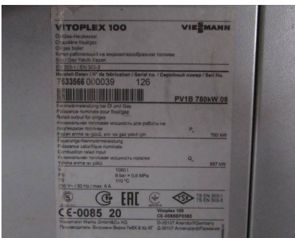
Pampāļu ciema gāzes katlumājas aprīkojums ar Vitoplex 100 gāzes katlu 780kw (Inv. Nr. 400013)
