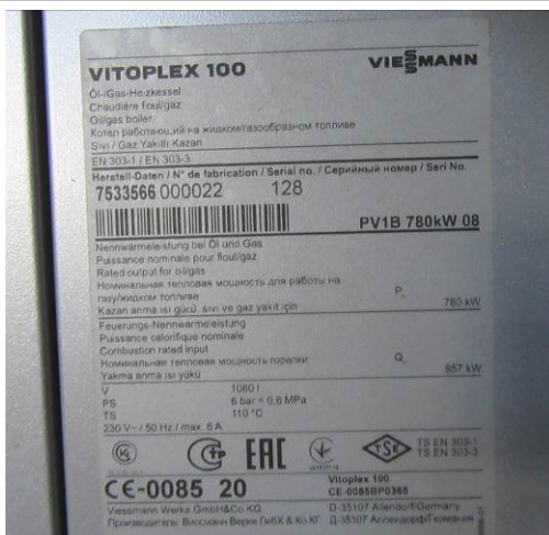
Ezeres ciema gāzes katlumājas aprīkojums ar Vitoplex 100 gāzes katlu 780kw (Inv. nr. 400012)
