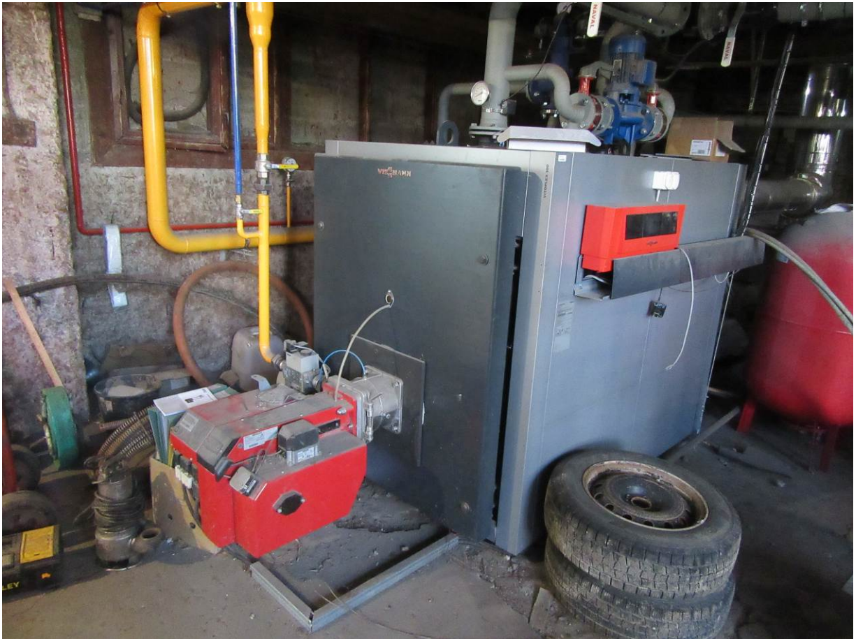
Ezeres ciema gāzes katlumājas aprīkojums ar Vitoplex 100 gāzes katlu 780kw (Inv. nr. 400012)
