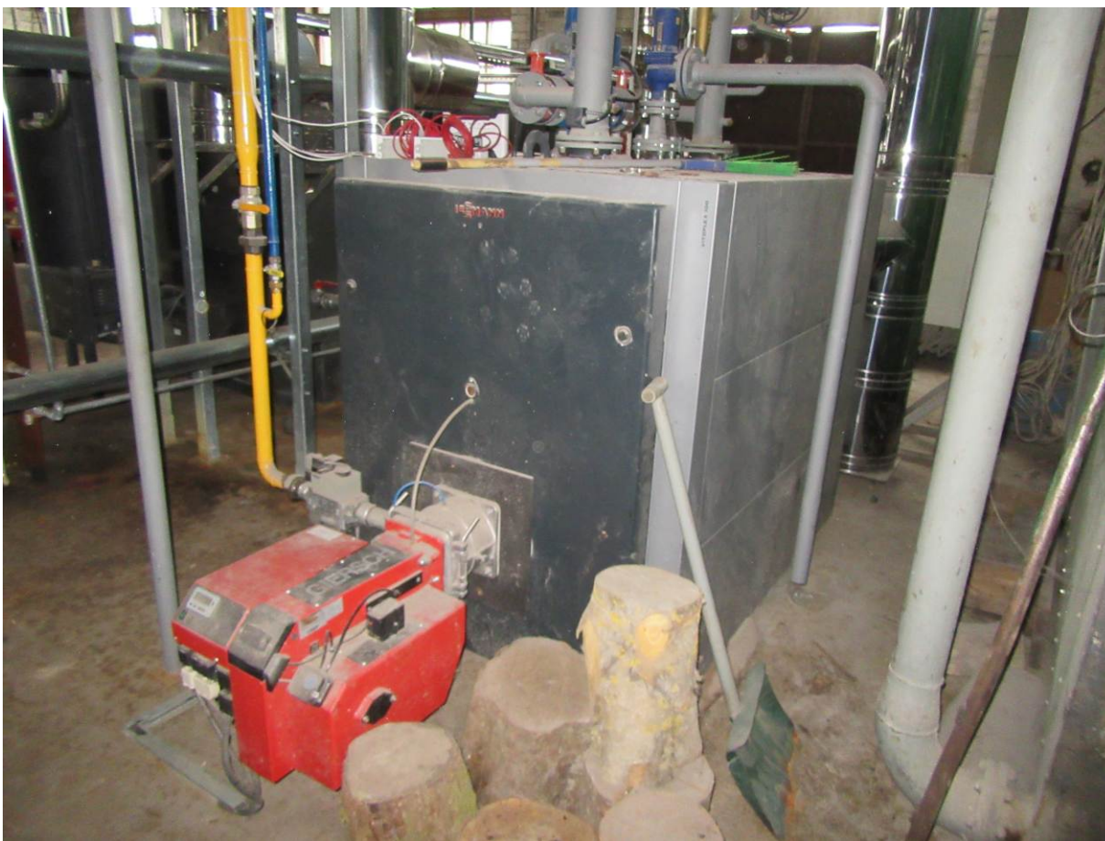
Pampāļu ciema gāzes katlumājas aprīkojums ar Vitoplex 100 gāzes katlu 780kw (Inv. Nr. 400013)
