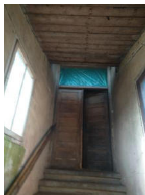
4.attēls. Kāpņu telpa
