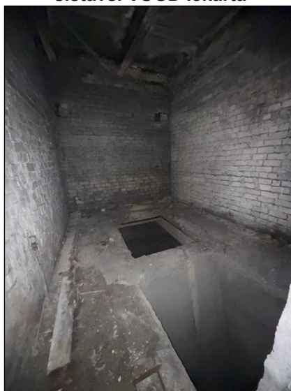
3.stāvs. Palīgtelpa, telpa nr.16
