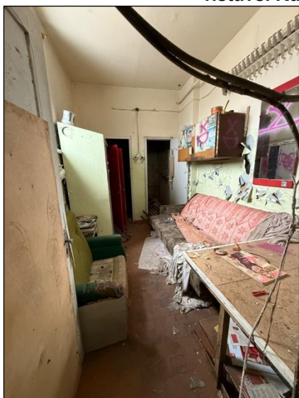
2.stāvs. Palīgtelpa, telpa nr.11
