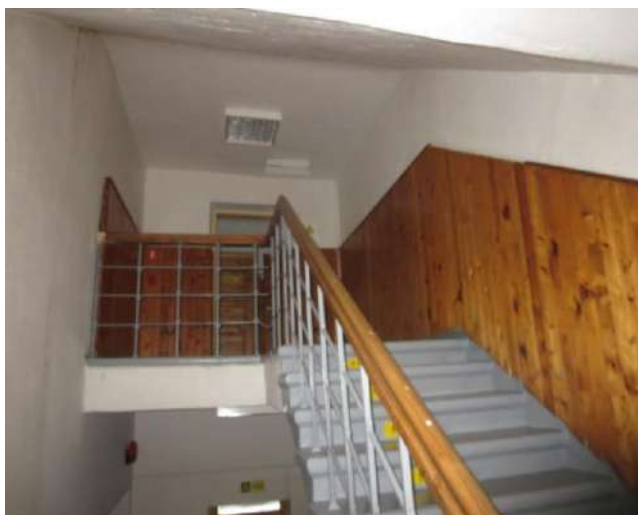
3.stāva kāpņu telpa
