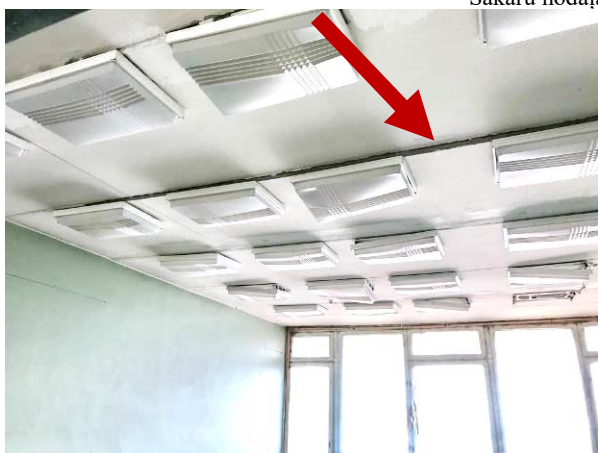
Sakaru nodaļas telpas iekšskats – redzama paneļu vertikāla nobīde
