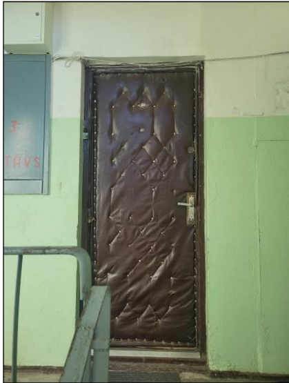
Kāpņu telpas (dzīvokļa ārdurvis)
