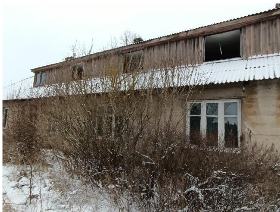
Ēkas fasāde ar dzīvokļa logiem
