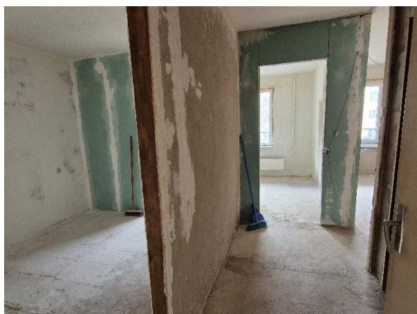
Gaitenis (telpa Nr.4), istaba (telpa Nr.1)
