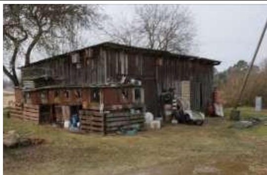
Būve (šķūnis) ar kadastra apzīmējumu 8470 003 0121 004 Būve (šķūnis) ar kadastra apzīmējumu 8470 003 0121 005
