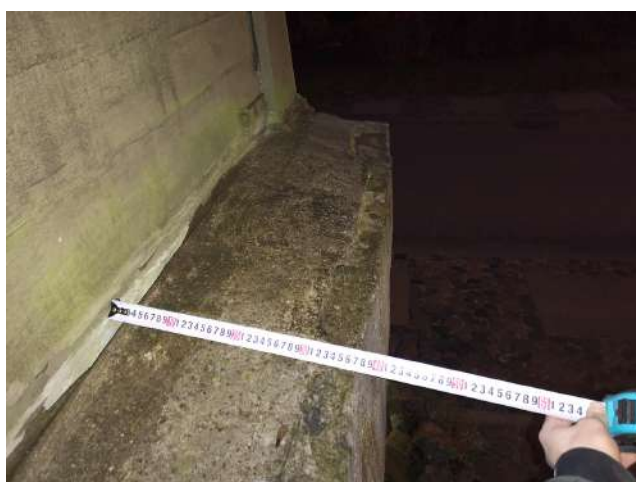
4.16. un 4.17.att. Masīva, pieaudzēta pamatu konstrukcijas ir atdalījusies no ēkas pamatkonstrukcijas, gar nesošo ārsienu un virspamatu, ēkas konstrukcijās iekļūst atmosfēras nokrišņu ūdeņi tās bojājot. Virspamatu daļas izvirzījums no ēkas nesošās sienas ir ~40cm.
