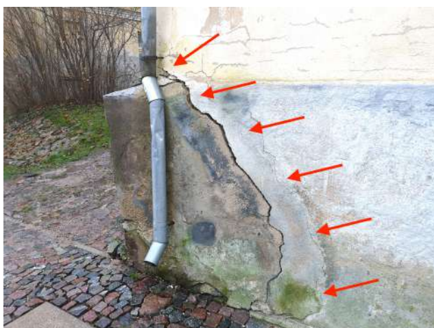
4.10. un 4.11.att. Plaisas un deformācijas progresē.
