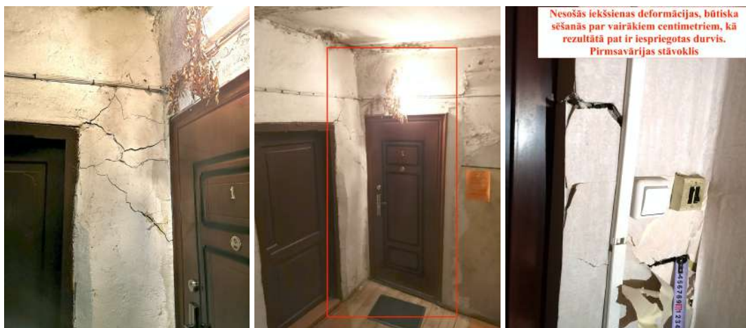
4.19., 4.20. un 4.21.att. Konstatēta nesošās iekšsienas deformācija/ nosēšanās par ~3cm, kā rezultātā ir iespiegotas durvis.
