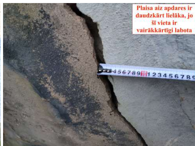
4.9.att. Ēkas ZR puse. Būtiski deformējas pamati, atdalās no ēkas pamatkonstrukcijas.
