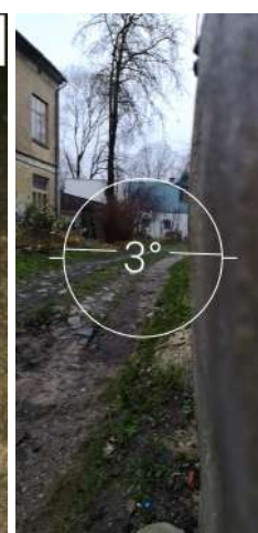
4.16. un 4.17.att. Masīva, pieaudzēta pamatu konstrukcijas ir atdalījusies no ēkas pamatkonstrukcijas, gar nesošo ārsienu un virspamatu, ēkas konstrukcijās iekļūst atmosfēras nokrišņu ūdeņi tās bojājot. Virspamatu daļas izvirzījums no ēkas nesošās sienas ir ~40cm.
