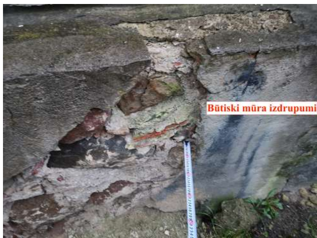
4.12. un 4.13.att. Ēkas ZR stūris. Masīva, pieaudzēta mūra pamatu konstrukcija
