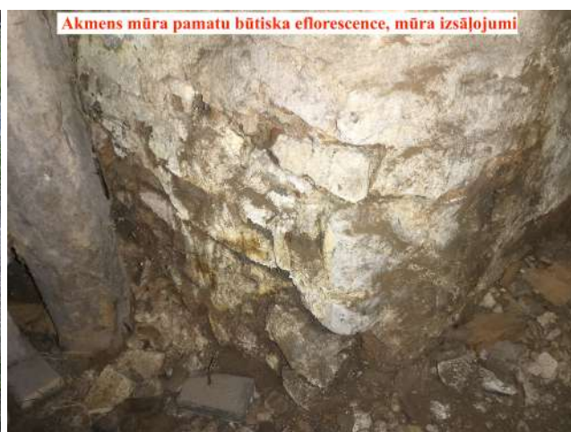
4.15.att. Pamatu būtiski bojājumi, izskalojumi pagrabā
