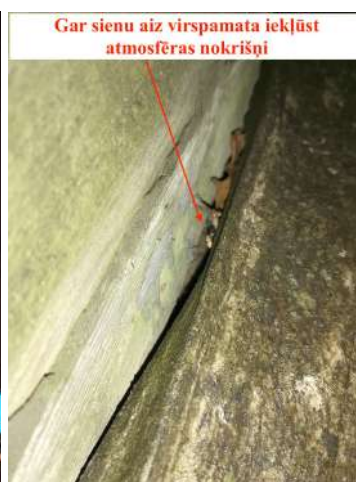
4.16. un 4.17.att. Masīva, pieaudzēta pamatu konstrukcijas ir atdalījusies no ēkas pamatkonstrukcijas, gar nesošo ārsienu un virspamatu, ēkas konstrukcijās iekļūst atmosfēras nokrišņu ūdeņi tās bojājot. Virspamatu daļas izvirzījums no ēkas nesošās sienas ir ~40cm.
