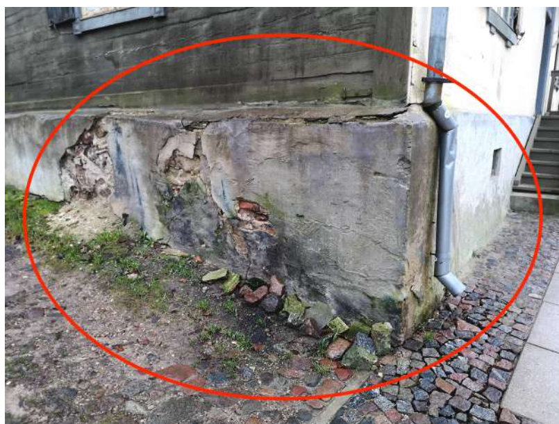
4.9.att. Ēkas ZR puse. Būtiski deformējas pamati, atdalās no ēkas pamatkonstrukcijas.
