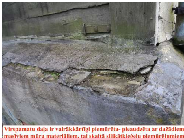
4.12. un 4.13.att. Ēkas ZR stūris. Masīva, pieaudzēta mūra pamatu konstrukcija
