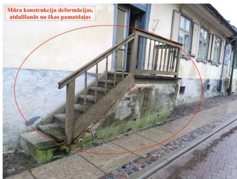
4.28.att. Ieejas kāpnes ēkas R pusē, to deformācijas
