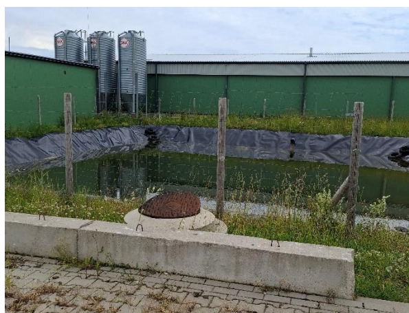
Ugunsdzēsības ūdens rezervuārs
