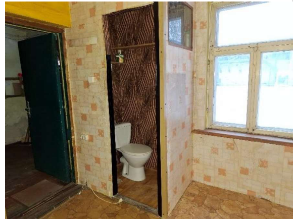
Ar vieglas konstrukcijas sienām nodalīta tualetes zona
