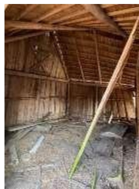
Būve (kūts) ar kadastra apzīmējumu 8456 005 0126 002
