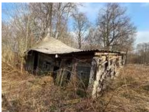
Būve (kūts) ar kadastra apzīmējumu 8456 005 0126 002
