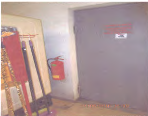
Fotofiksācija Nr.5 - virs ugunsdzēsamajiem aparātiem nav norādījuma zīmju
