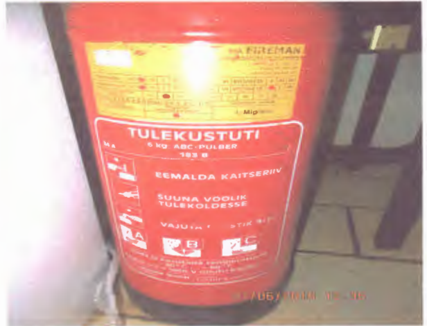
Fotofiksācija Nr.8 - kafējnīcas telpās ugunsdzēsamajiem aparātiem beidzies derīguma termiņš
