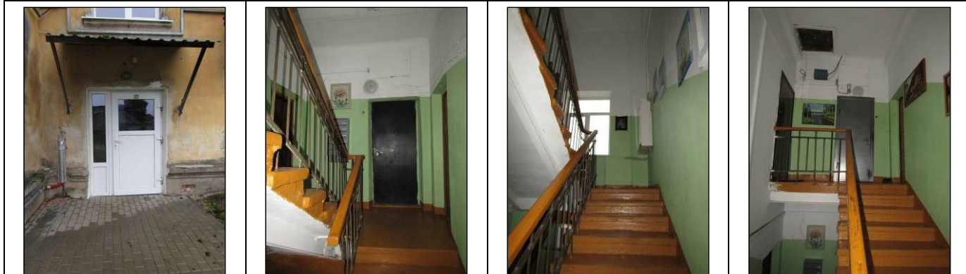
Skats uz kāpņu telpas ārdurvīm, kāpņu telpu
