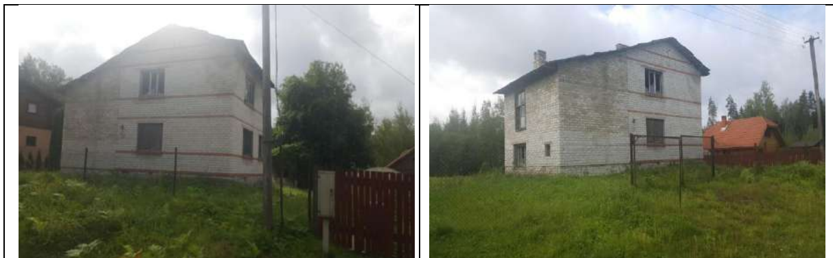
Skats uz vērtējamo objektu no koplietošanas ceļa Z un ZA virziens
