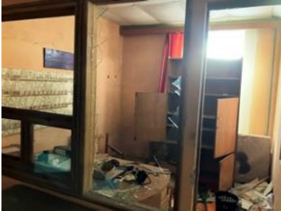
Dežuranta telpa 1.stāvā
