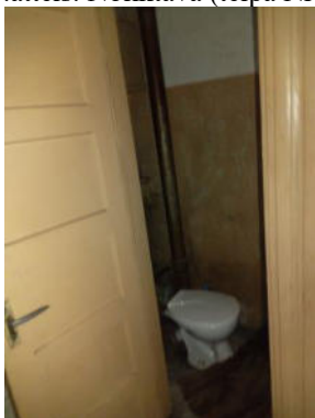
13.attēls. Tualete (telpa Nr.5)
