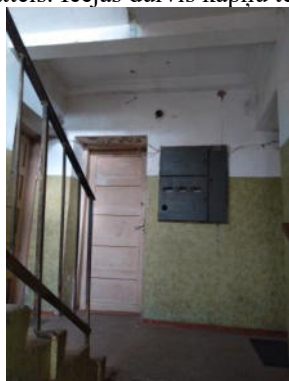
5.attēls. Kāpņu telpa
