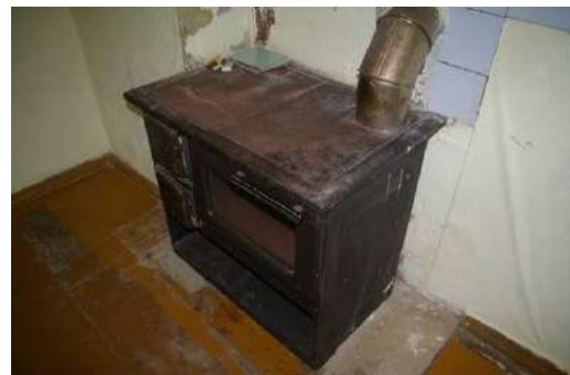
Dzīvojamā ēka-internāts ar kadastra apzīmējumu 6450 005 0120 002, 2.stāvs, krāsns
