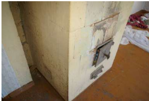
Dzīvojamā ēka-internāts ar kadastra apzīmējumu 6450 005 0120 002, 2.stāvs, krāsns
