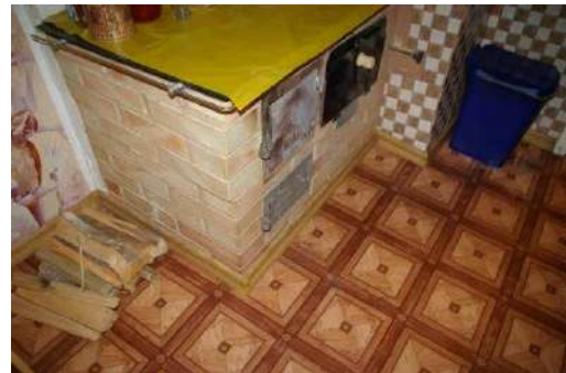
Dzīvojamā ēka-internāts ar kadastra apzīmējumu 6450 005 0120 002, 2.stāvs, plīts
