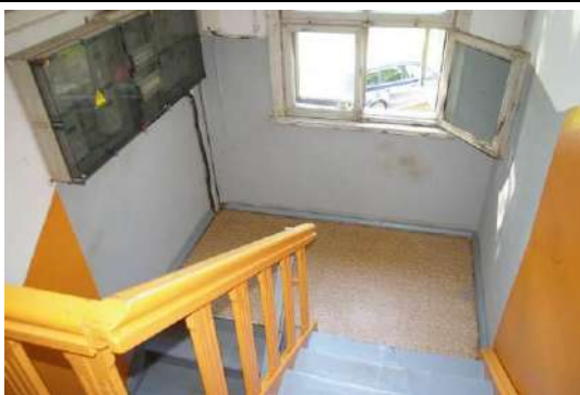
Būve ar kadastra apzīmējumu 6405 010 0059 001, koplietošanas telpa
