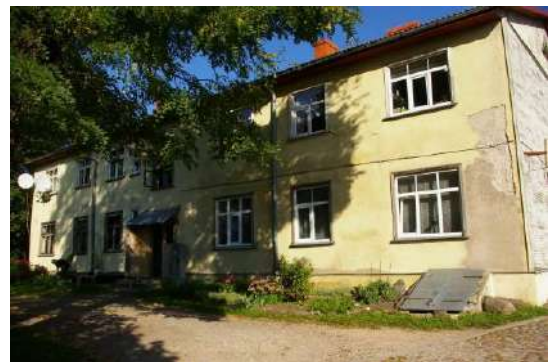
Būve ar kadastra apzīmējumu 6405 010 0059 001, kopskats no Tebras ielas puses
