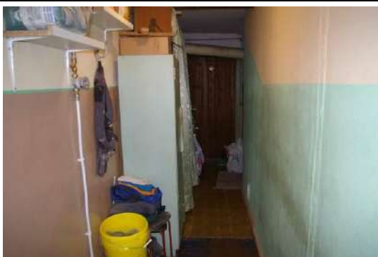
Būve ar kadastra apzīmējumu 6405 010 0059 001, koplietošanas telpa
