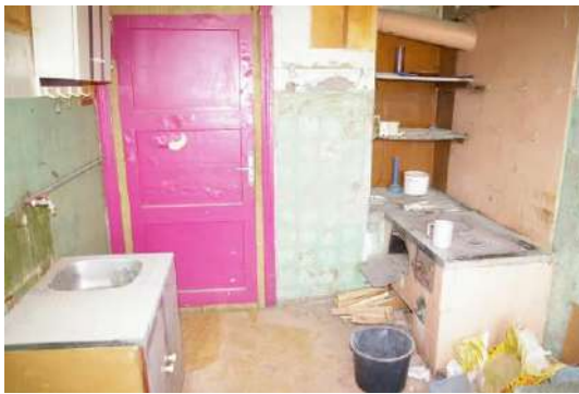
Būve ar kadastra apzīmējumu 6405 010 0059 001, dzīvoklis Nr.10, telpa Nr.2
