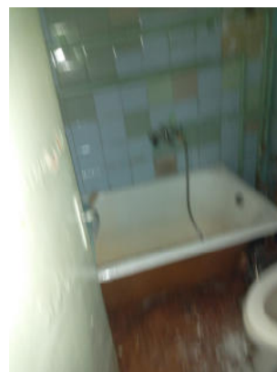
12.attēls. Tualete (telpa Nr.4)
